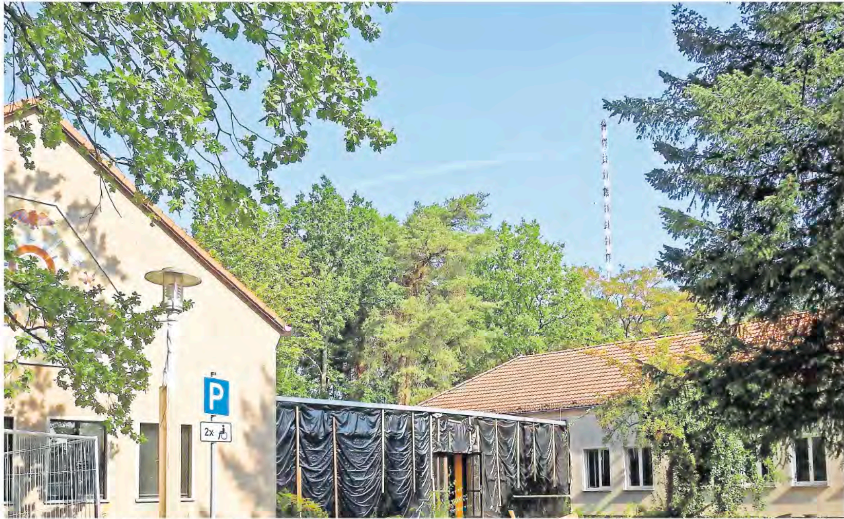
Der Umbau des alten Speisetraktes zum Multifunktionsaal soll bis Mitte nächsten Jahres abgeschlossen sein
